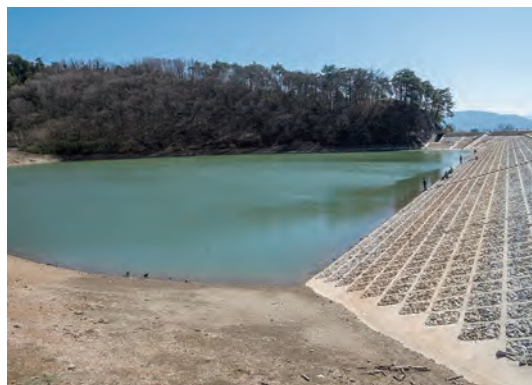
図3-16 竜ヶ池：大正6年（1917）に農業用のため池として耕地整理組合により築造されたアースダム
